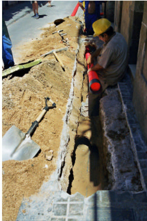
Fotografia 5. Col·locació dels tubs per a cable elèctric a la rasa 100, tram 4, mirant cap al nord-oest.
